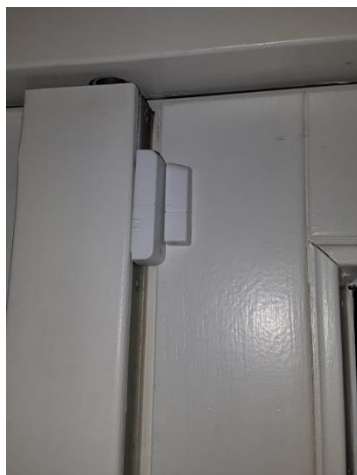
Figuur 5 - Dubbele deuren, Sensor op linkse deur, magneet op rechtse deur
