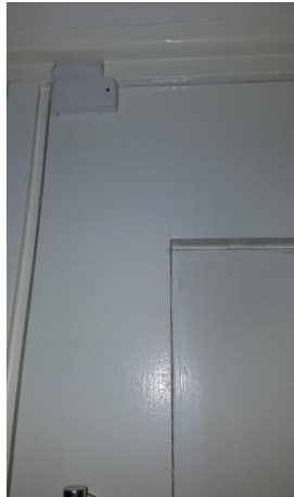
Figuur 3 - Sensor op de deur, magneet op het kozijn.
