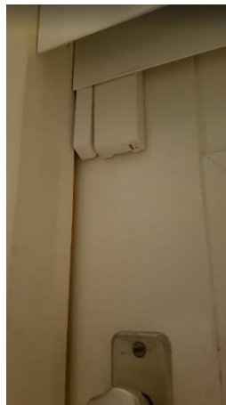
Figuur 4 - Sensor op de deur, magneet op het kozijn met plakzijde naar links.
